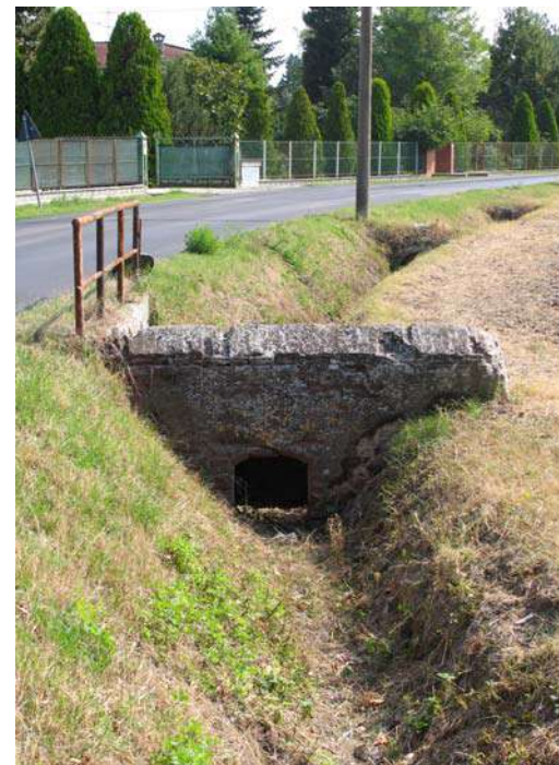
4/1- Ponticello in muratura; 4/2- Paratoia per la regimazione delle acque accanto alla Strada Massumatico.
