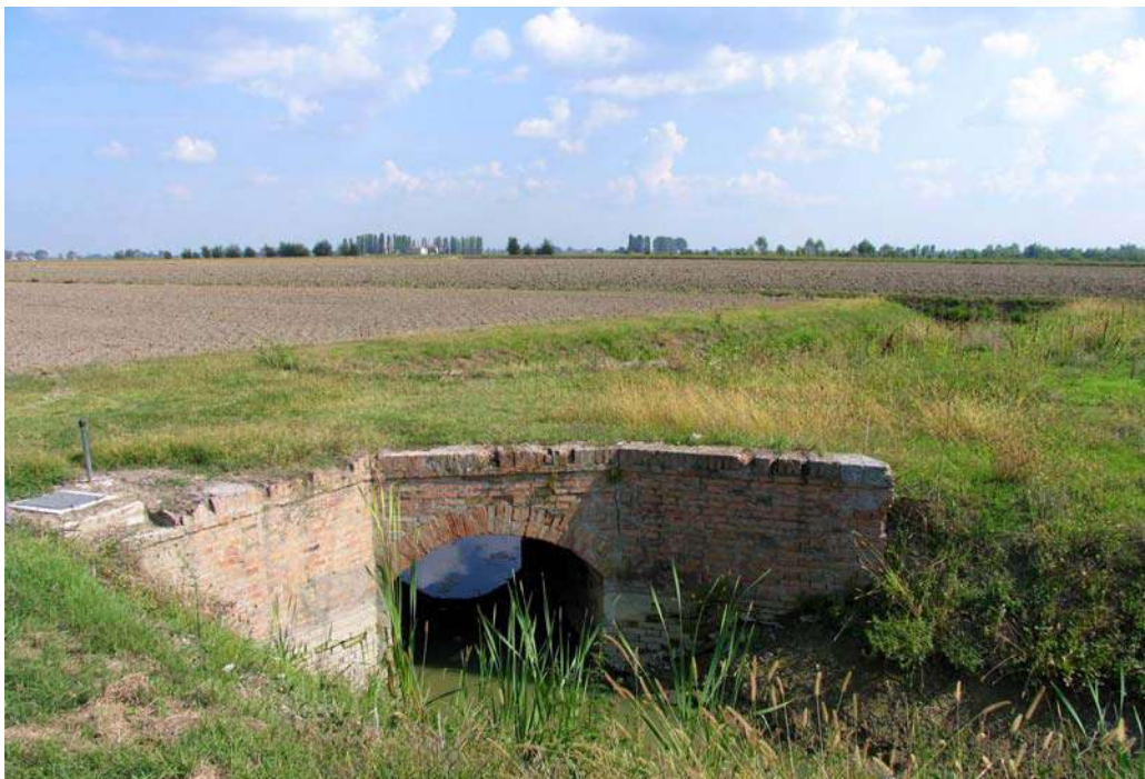
4/1- Ponticello in muratura; 4/2- Paratoia per la regimazione delle acque accanto alla Strada Massumatico.
